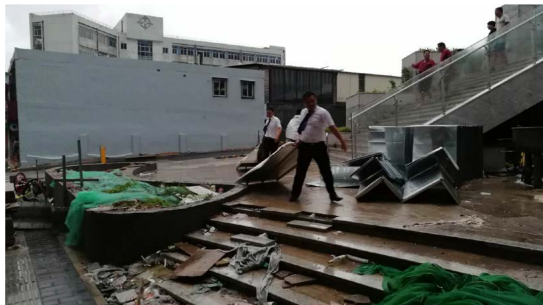
物业公司进行现场清理恢复工作
