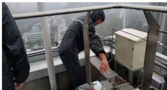
物业公司员工冒雨进行设备维护工作
