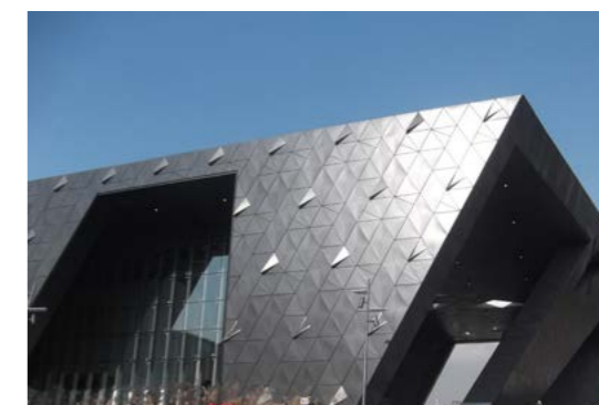
由方大建科承建幕墙工程的深圳万科前海企业公馆—特区馆
