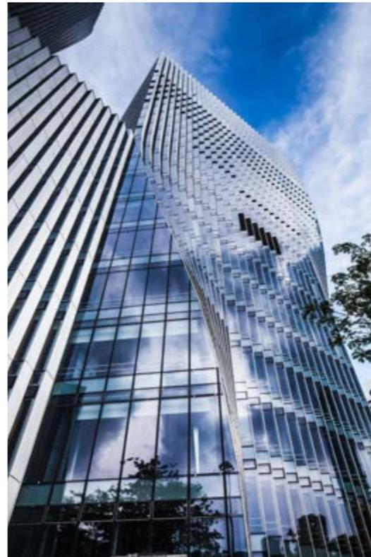
位于深圳市福田区，其幕墙大面积采用了由玻璃幕墙和波纹板幕墙组合而成的锯齿状幕墙，这是该建筑外观主要亮点之一。其外立面设计灵感来自植物棕榈叶，这种层叠结构使建筑整体富有灵动性，同时也有节能环保效果。
