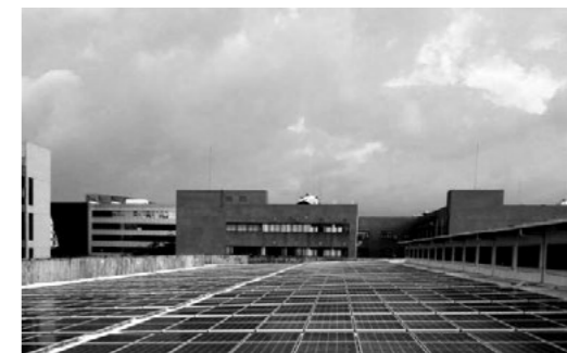
方大东莞松山湖工业园区 2MW 分布式光伏发电项目 3# 厂房组件安装
