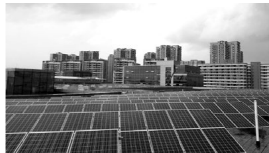
方大东莞松山湖工业园区 2MW 分布式光伏发电项目 2# 厂房组件安装
