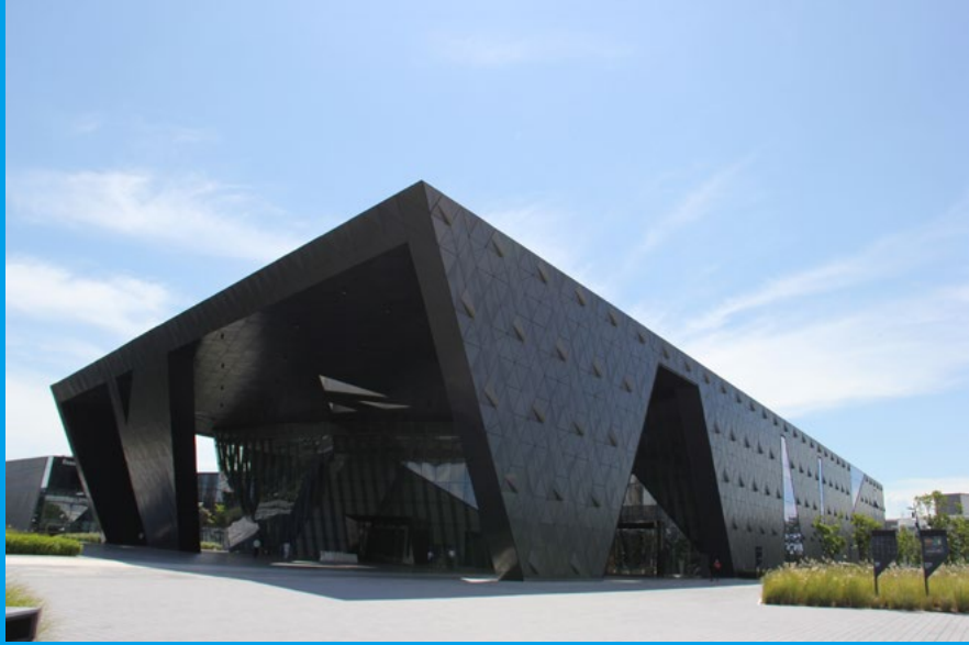
由建科集团承建幕墙工程的深圳万科前海企业公馆
