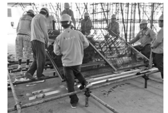
玻璃运上轨道
