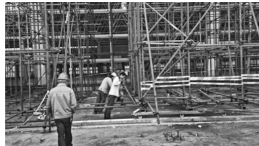
移动式脚手架开始“行走”
