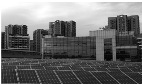
方大东莞松山湖工业园区 2MW 分布式光伏发电项目 1# 厂房组件安装
