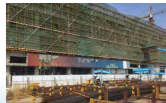
无锡万达茂幕墙安装正在紧张有序地进行
