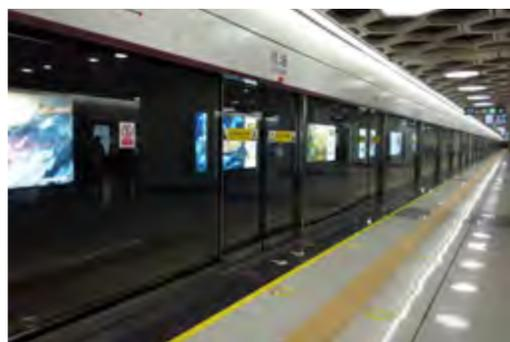
采用方大屏蔽门系统的深圳地铁11号线
