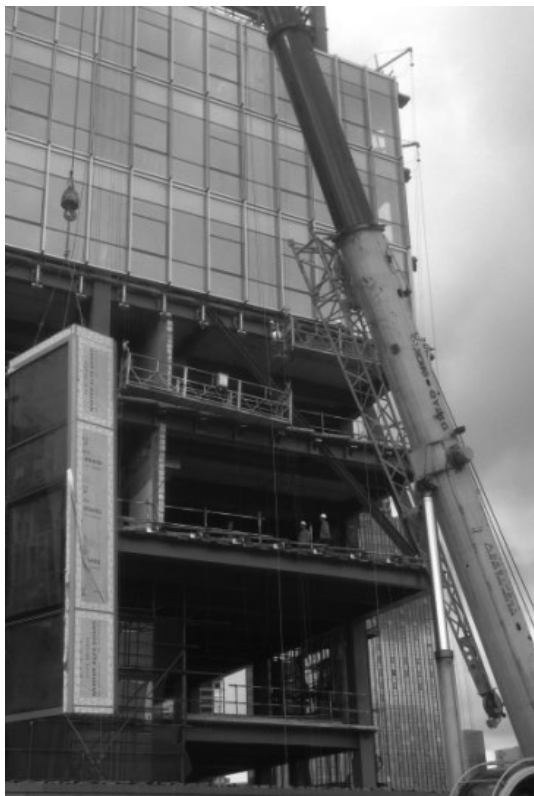
吊车运送幕墙板块
