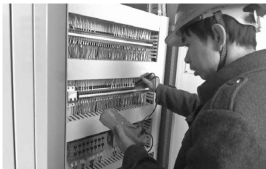
工程师正在检测线路设备
