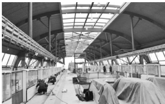
项目部以高昂热情施工
