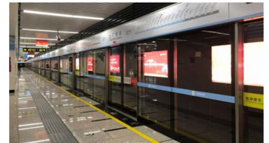
兰州地铁 1 号线一期工程开通试运营
