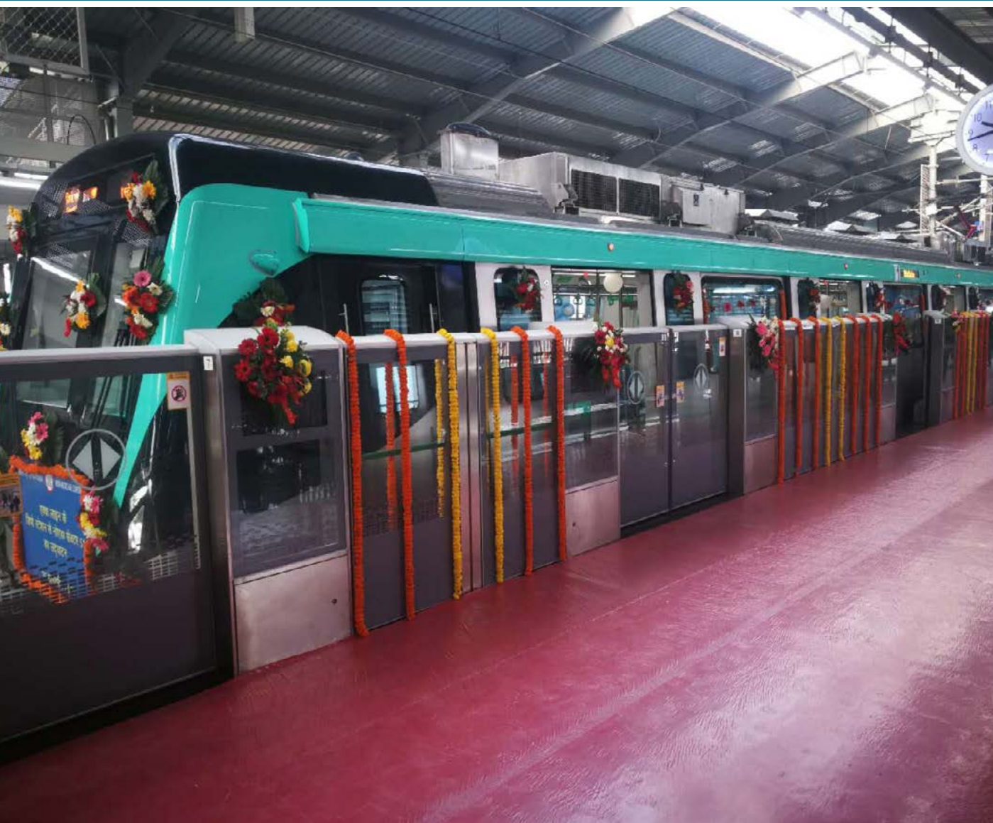
由方大智创承建屏蔽门系统的 印度新德里地铁诺伊达线
