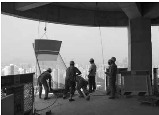
工人们正在安装幕墙板块
