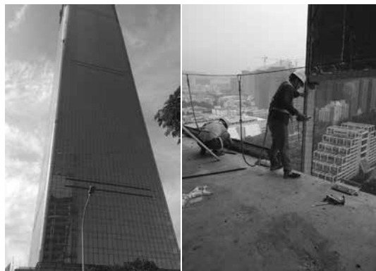
中国储能大厦幕墙工程项目全景及施工效果图
