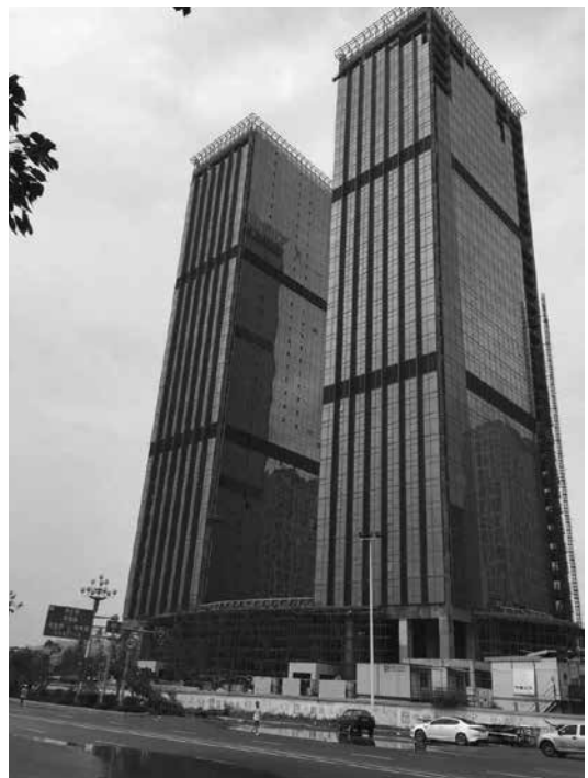
图为台风过后现场图
