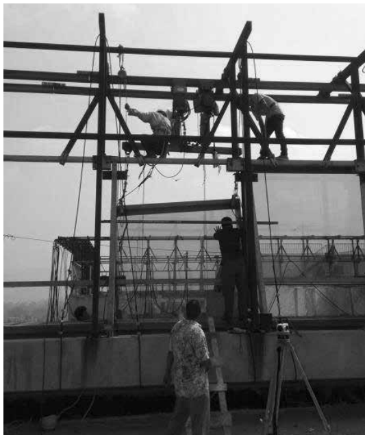
工人们正在安装幕墙板块
