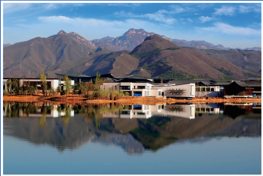
方大承建幕墙工程的2014APEC峰会会址 ——北京怀柔雁西湖项目
