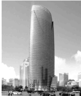
深圳文博大厦项目
