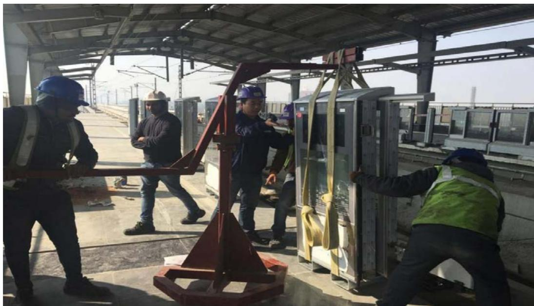
施工队员在工程师的协助下安装地铁站台安全门
