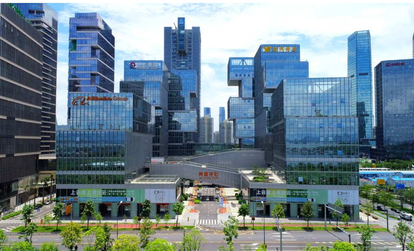
由方大建科承建幕墙工程的 深圳·阿里巴巴阿里云研发中心
